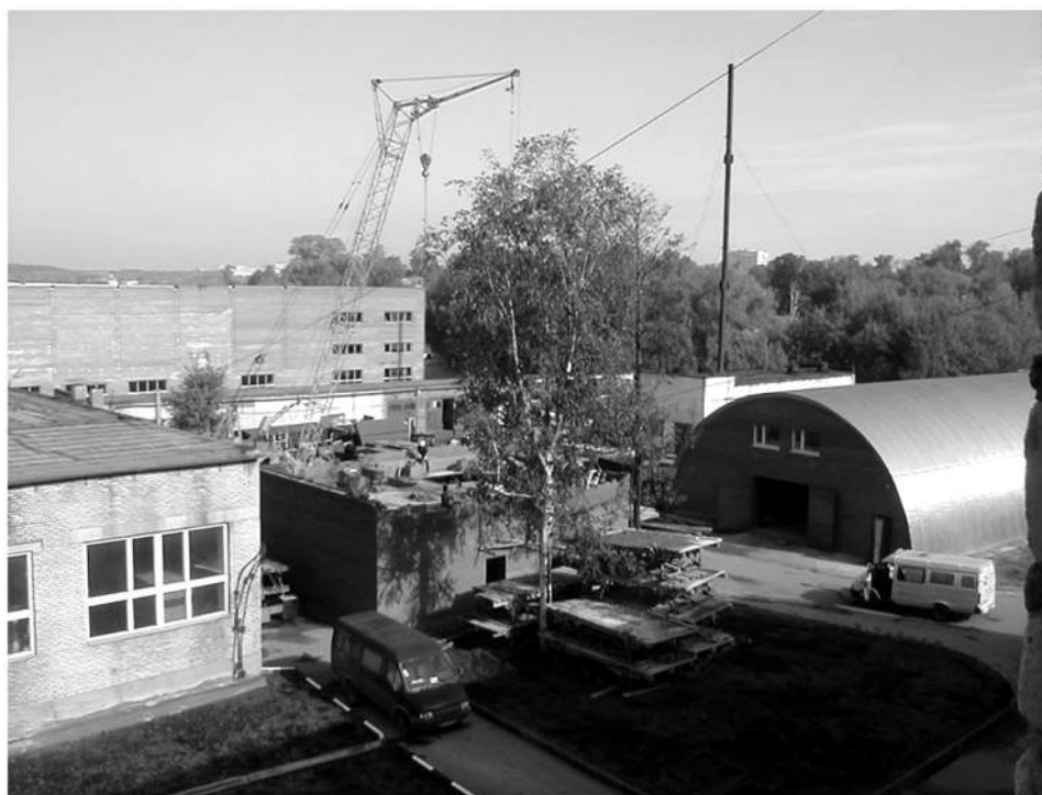
Рис. 3. Строительство испытательного стенда, май 2001 года
